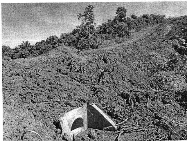
Obras em linhas rurais de Juína – Acervo Próprio
